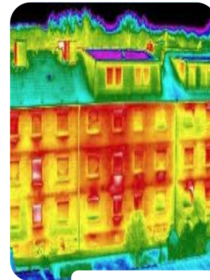
Material de construcción
